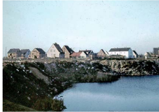
Die Müllkippe Lehmkuhle im Jahr 1959
